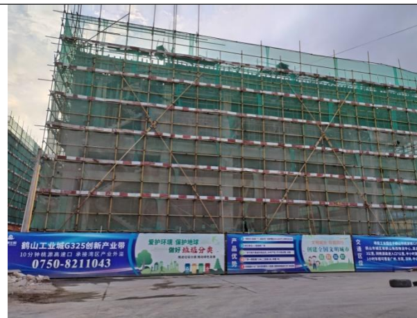
南面在建厂房
