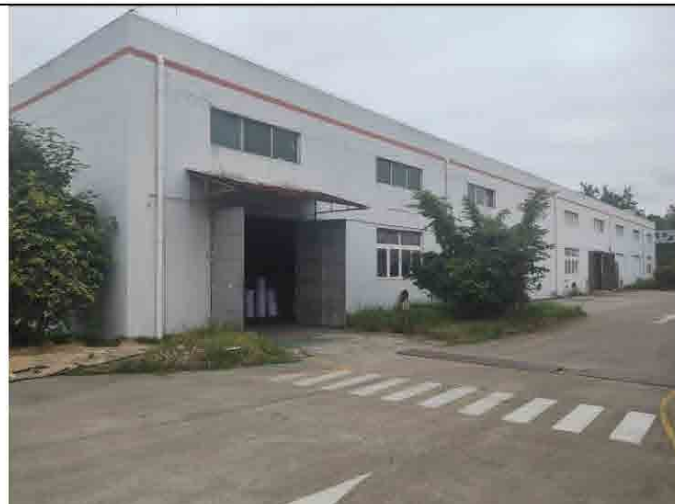
项目北面：广东东旭化学工业制造有限公司甲类仓库
