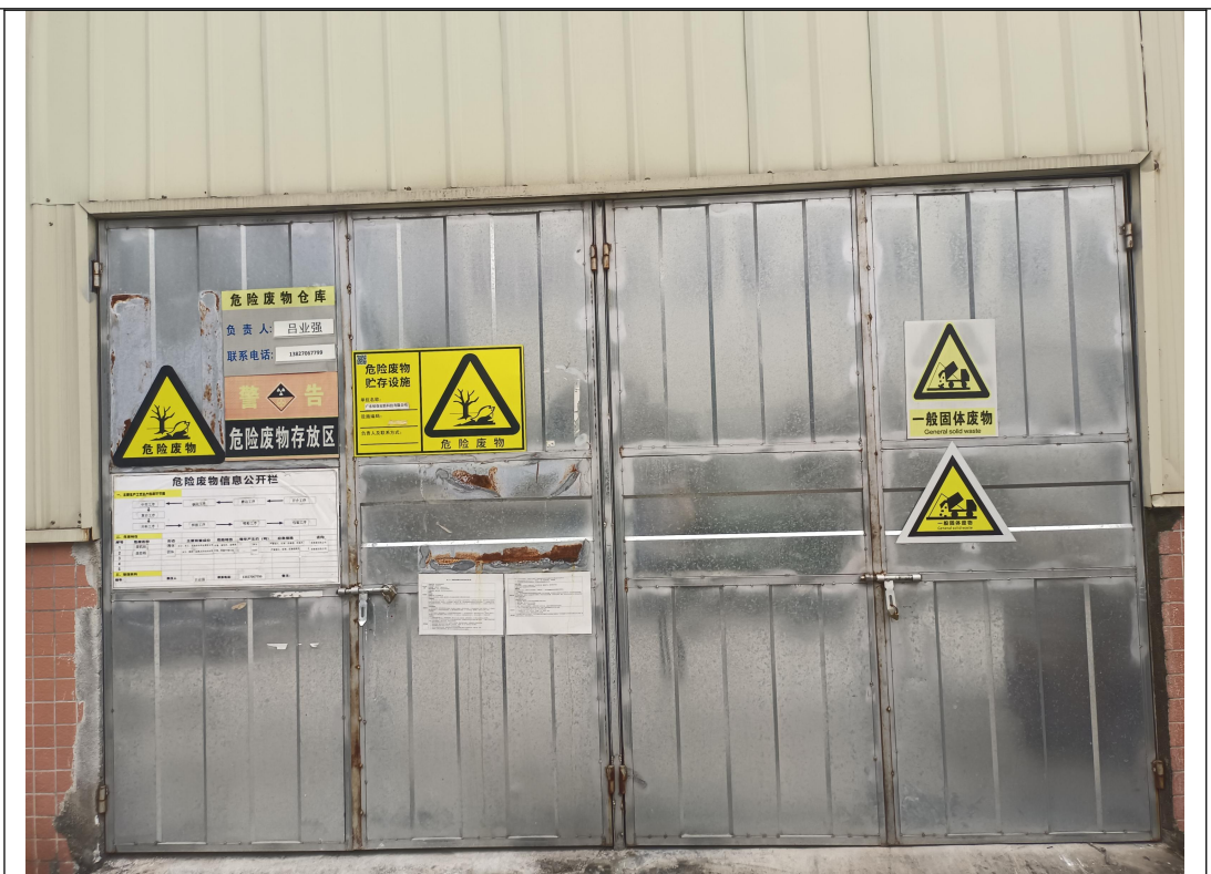
一般固体废物间和危险废物暂存间
