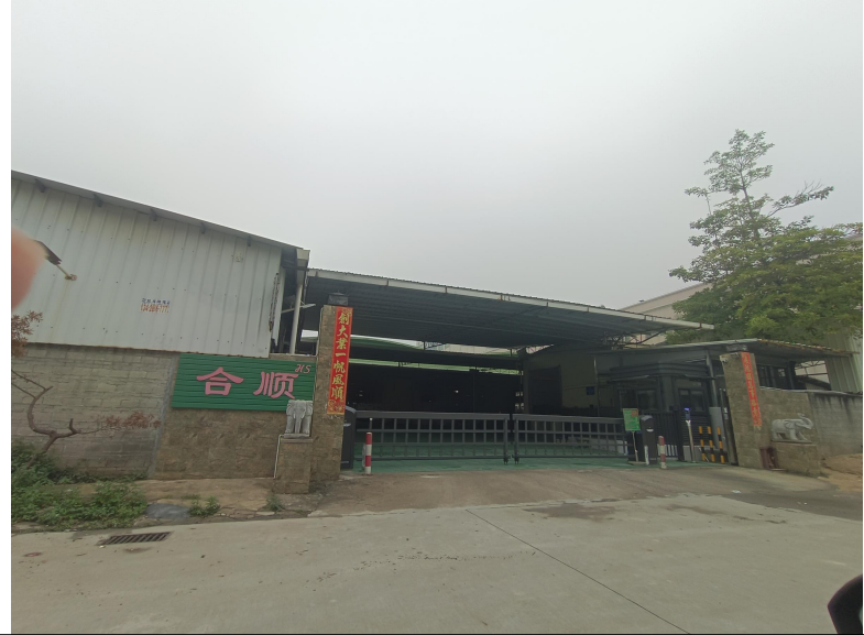
项目西北侧-合顺五金塑料厂
