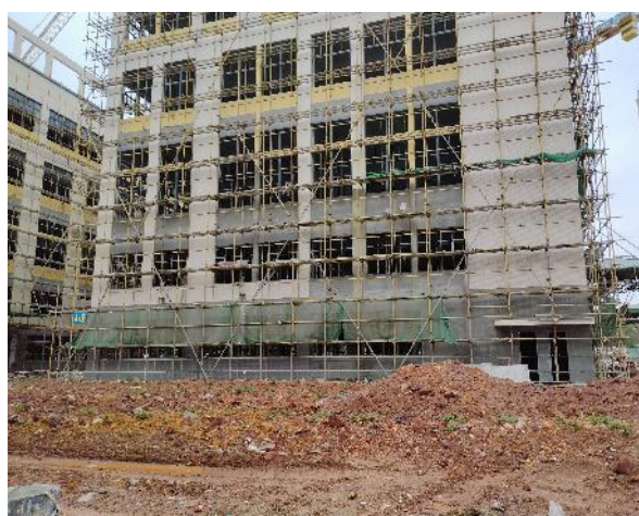
西面 在建厂房
