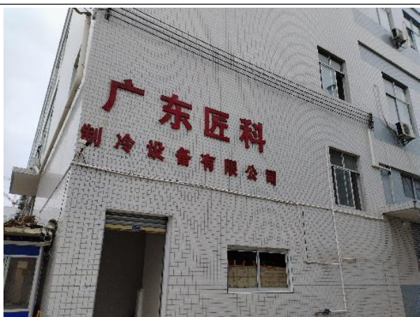
东面 广东匠科制冷设备有限公司
