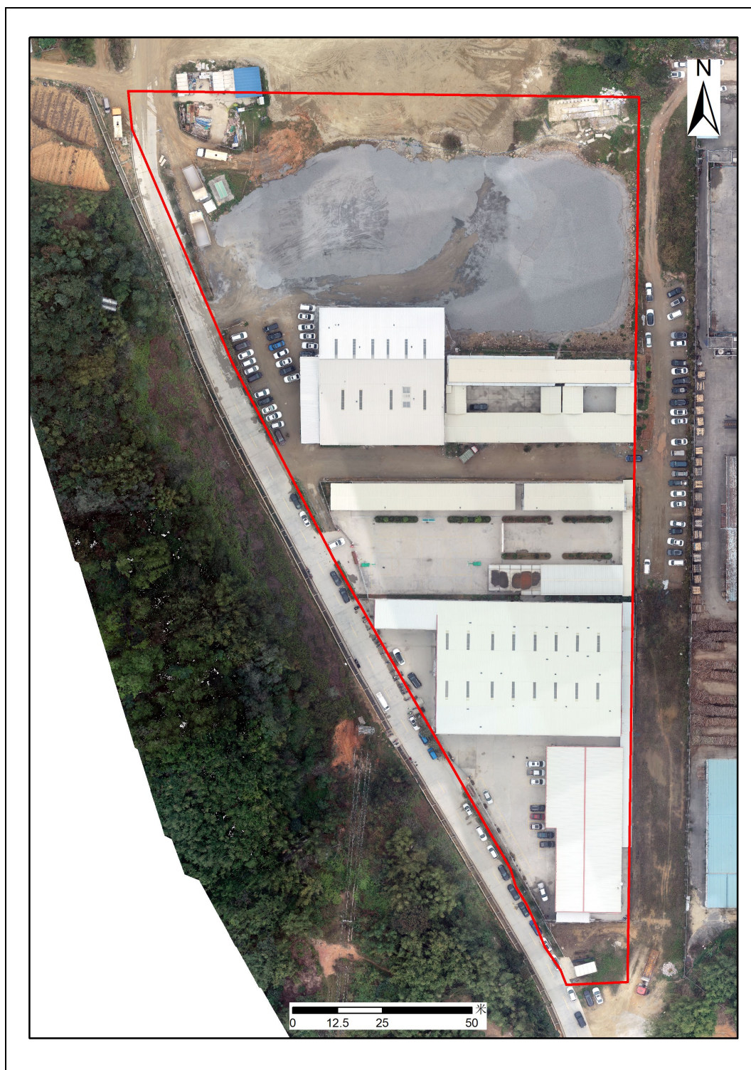
图 2 临时用地土地利用情况航拍影像图（2024 年 1 月）
