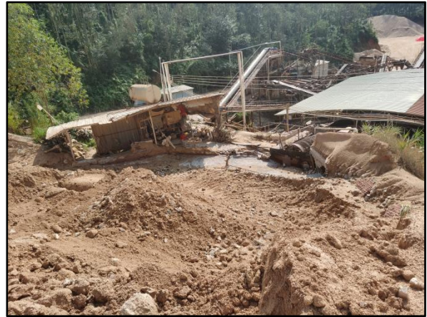
冲洗投料位置
