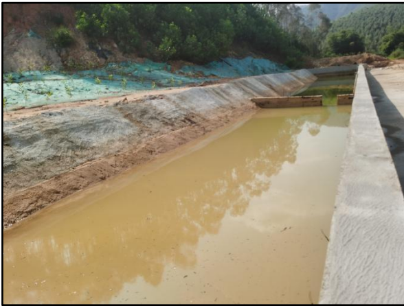
初期雨水沉淀池
