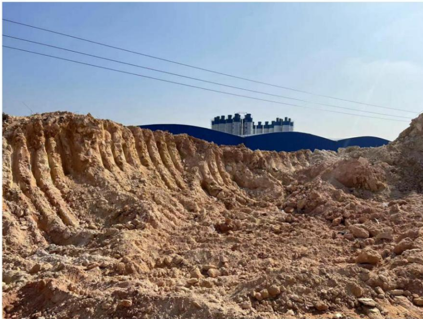
照片 4 地块现状
