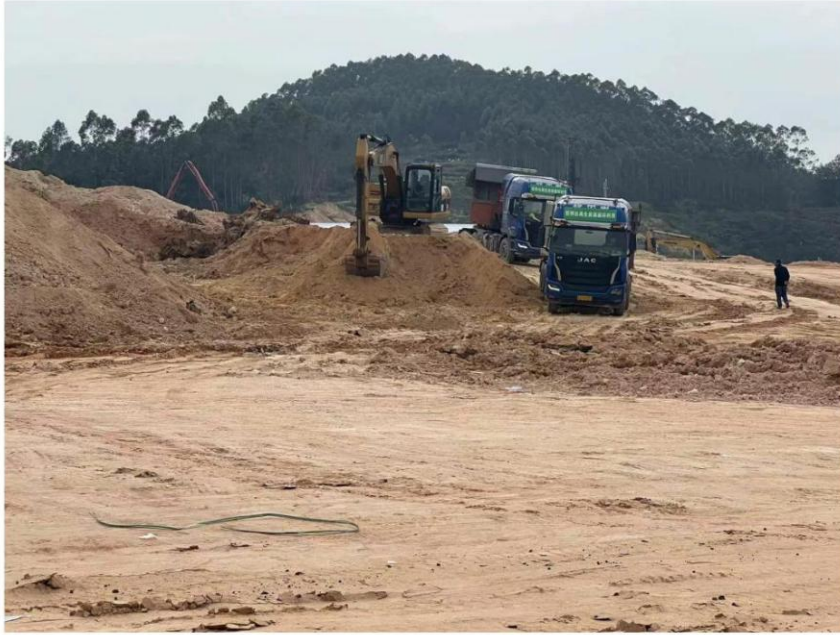
照片 3 地块现状
