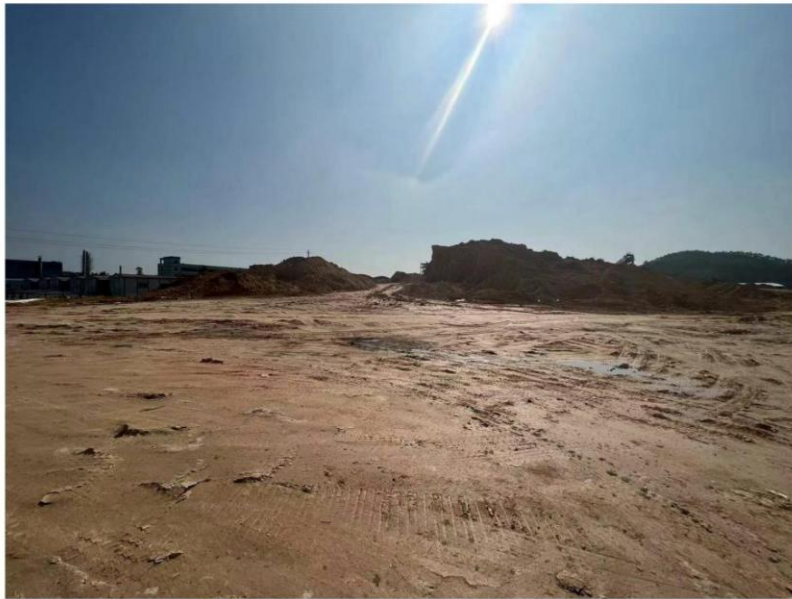
照片 2 地块现状
