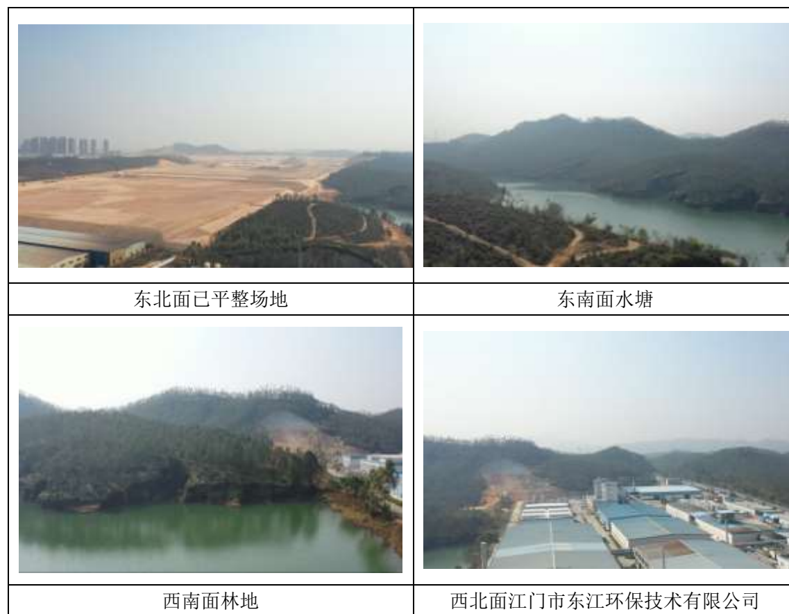
图 3.1-4 四置情况现状照片
